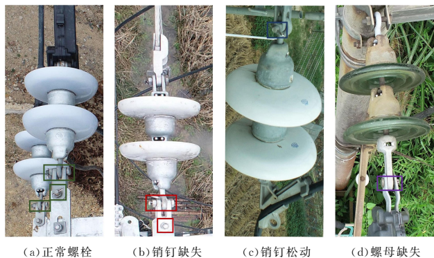
图2 螺栓及其缺陷示例
