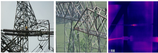
图 2 航拍巡检绝缘子图像特征鲁棒性差的样例
